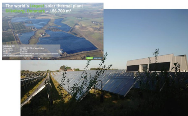
図24: デンマークの太陽熱地域熱供給施設(ARCON-SUNMARK 社資料ほか)
