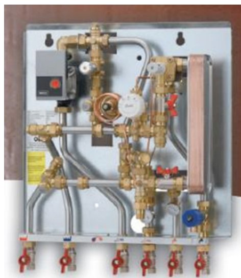
図22: 各住戸の熱交換器の構造 (出所: Danfoss 社資料)
