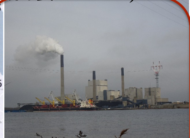
5.石炭火力CHP(500MW) DHの約50%を供給
