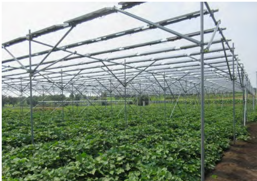
露地の畑の上部にパネルを設置
