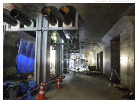
西2丁目地下歩道 天井部の冷水・温水導管幹線
