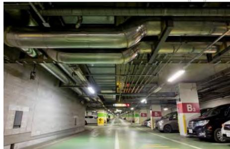
北一条駐車場 天井部の冷水導管幹線
