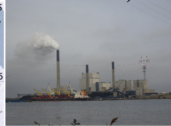
5.石炭火力CHP(500MW) DHの約50%を供給
