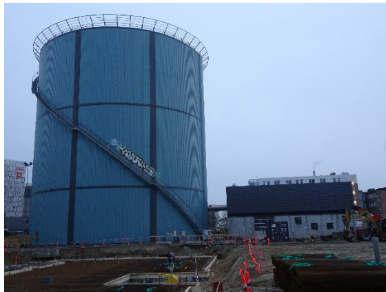
1. 蓄熱槽(1.2万m3)と ポンプ室
