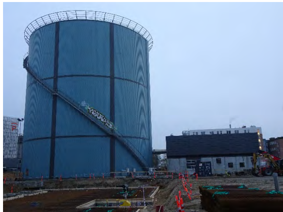
1. 蓄熱槽(1.2万m3)と ポンプ室
