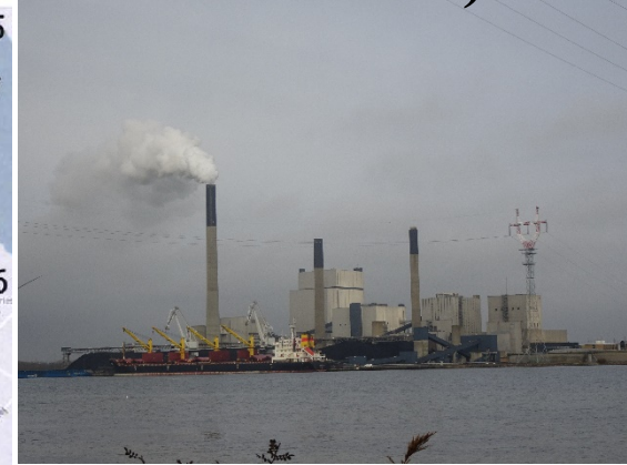
5.石炭火力CHP(500MW) DHの約50%を供給
