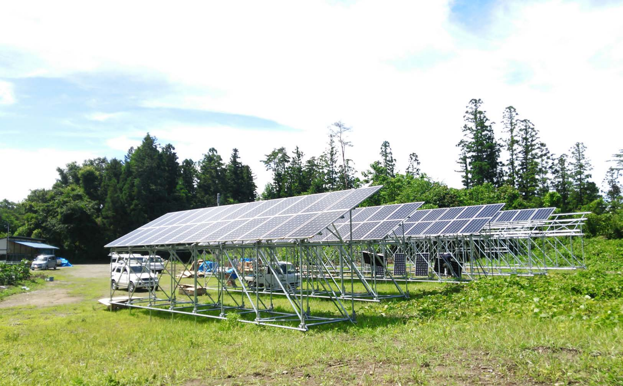
小規模（50 k w）発電所建設風景
