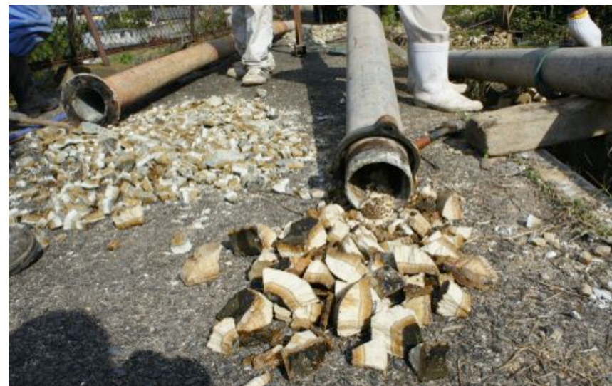
某源泉の配管清掃の様子
