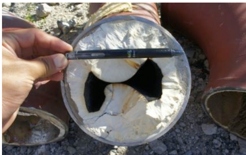
発電所の貯湯タンクまでの配管
